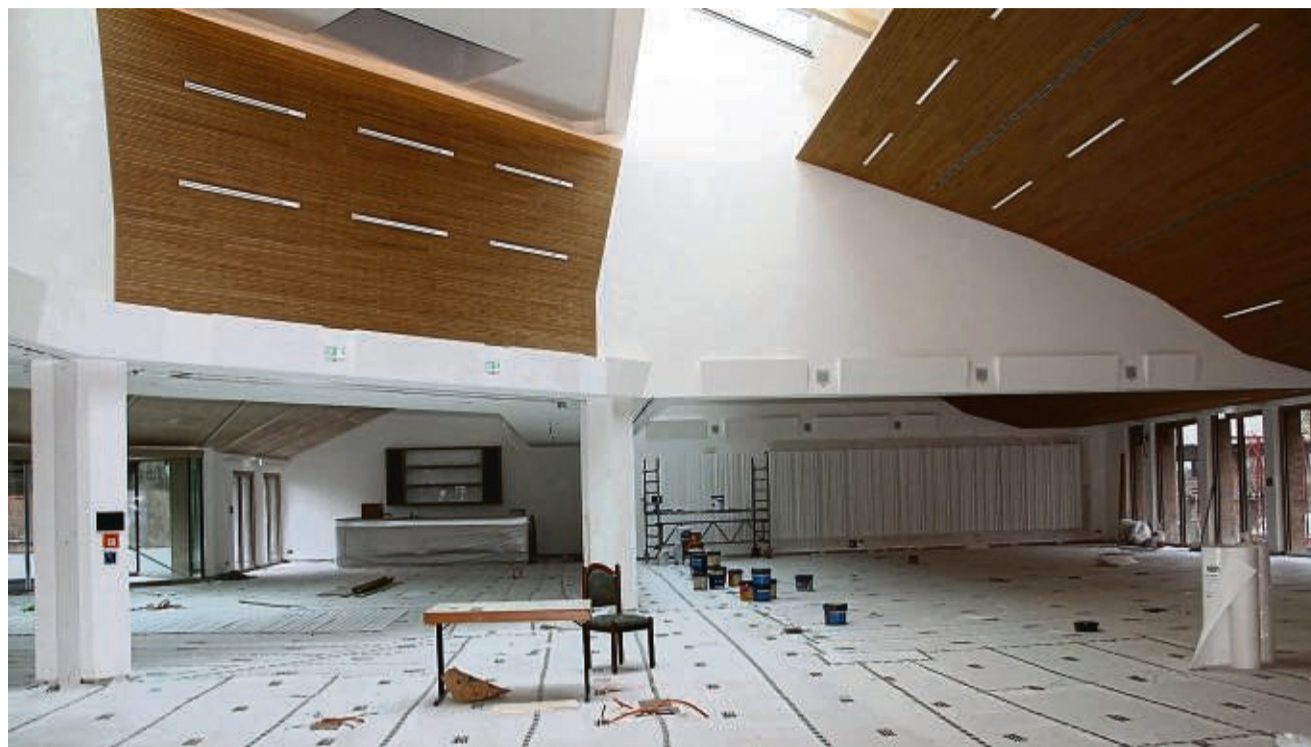
Noch Baustelle: Die Ederberglandhalle in Frankenberg wird seit November 2020 saniert, modernisiert und umgebaut. Sie soll am 8. März unter dem neuen Namen Philipp-Soldan-Forum wiedereröffnet werden. FOTO: GERHARD MEISER
